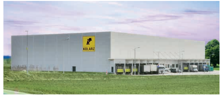
Logistikzentrum Müllendorf, Österreich | Logistics Center Müllendorf, Austria
